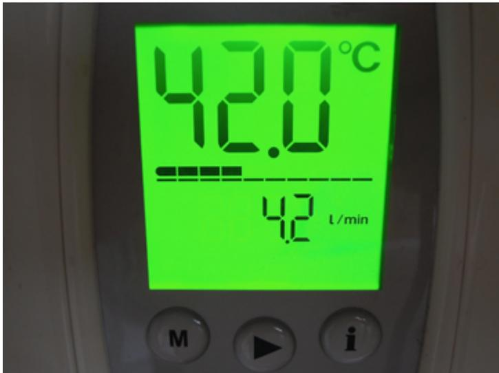
Abb. 13: Wasserstromangabe auf einem Durchlauferhitzer (HR\_Ph\_TF9\_Volumenstrom)
