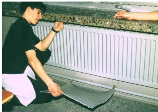
**Durch die Dämmung der Wand hinter dem Heizkörper wird die Effizienz des Heizkörpers erhöht**
