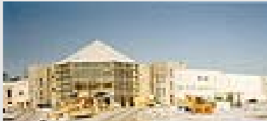
Müllerland im Rohbau
